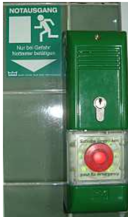
Taster zum Öffnen von geschlossenen Notausgangstüren
