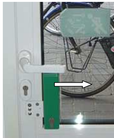
Fluchttürwächter (Öffnen der Tür durch seitliches Wegkippen des grünen Riegels)
